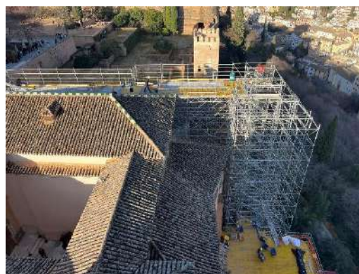
OBRA CUBIERTAS MEXUAR
