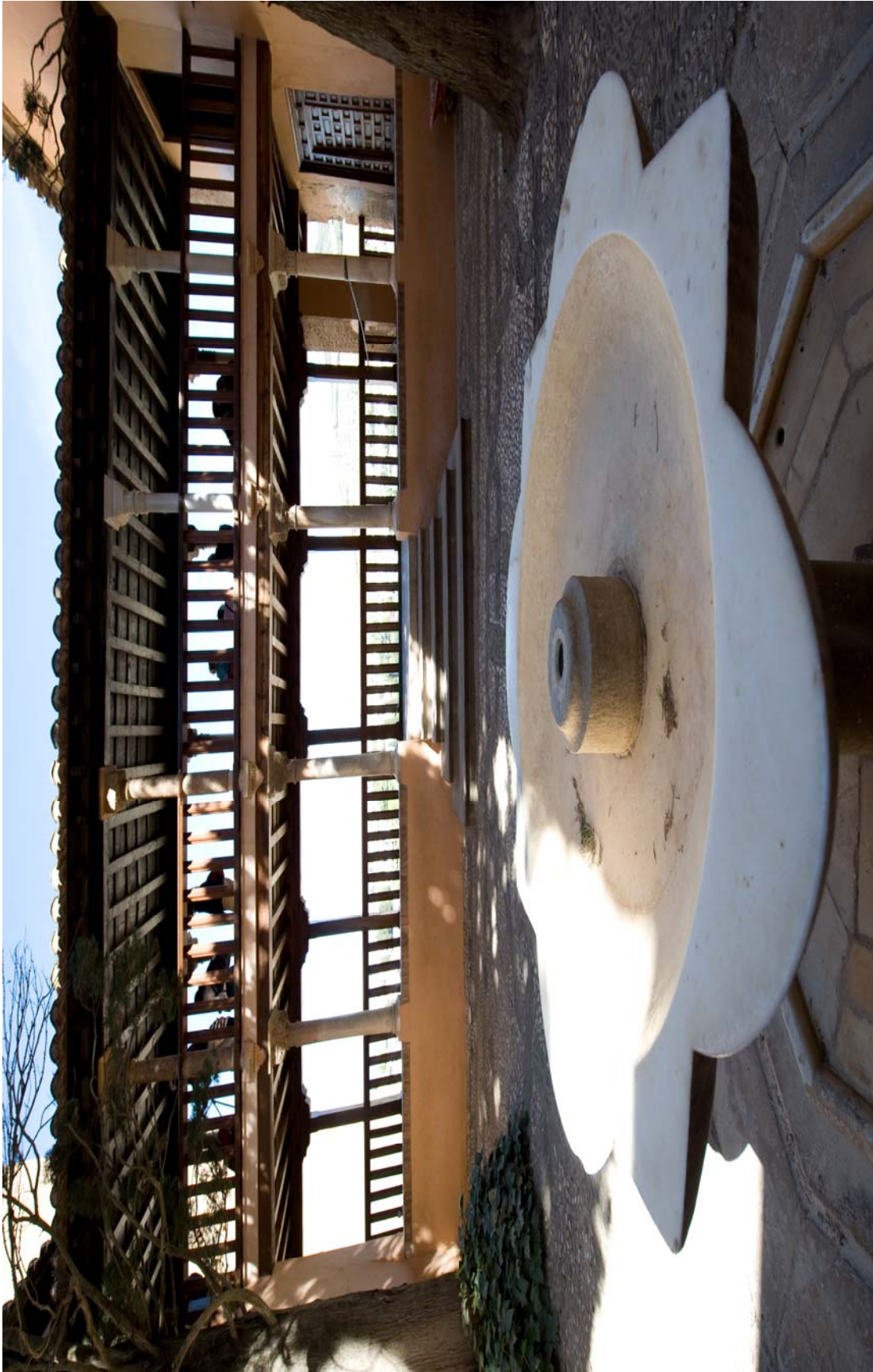
LÁMINA 113: GALERÍAS QUE UNEN LOS CUARTOS NUEVOS CON LA TORRE DE COMARES Y PATO DE LA REJA. FOTOS: FIESTAS MORENO, M.
