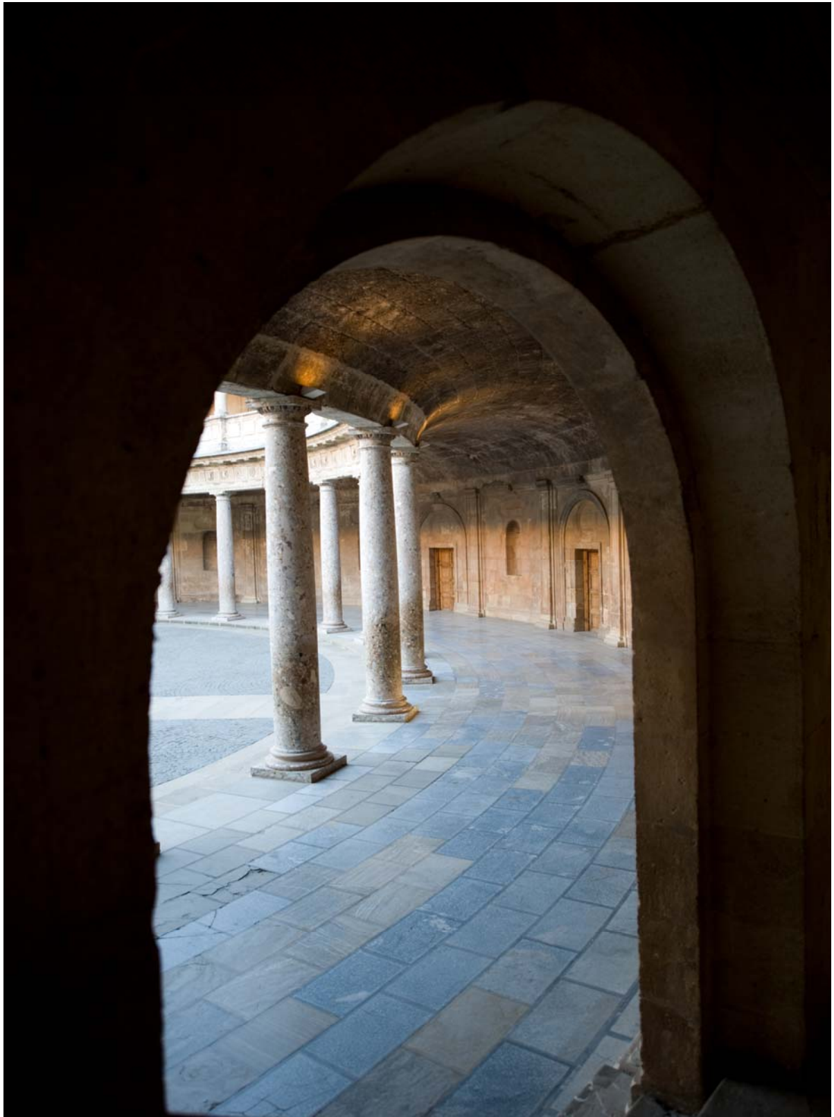
LÁMINA 125: DETALLE AMPLIADO DE LA BÓVEDA ANULAR. FOTOS: FIESTAS MORENO, M.
