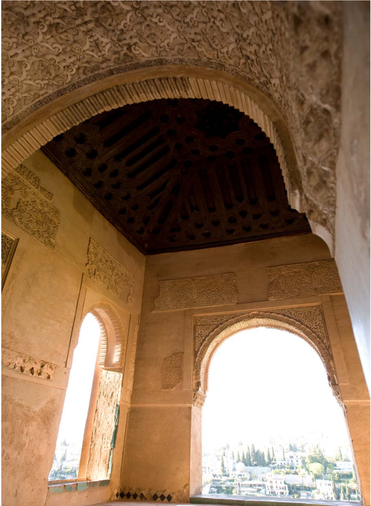
LÁMINA 36: PALACIO DE COMARES. DETALLE DEL ARTESONADO DE LA TORRE DEL CADÍ. FOTOS: FIESTAS MORENO, M.
