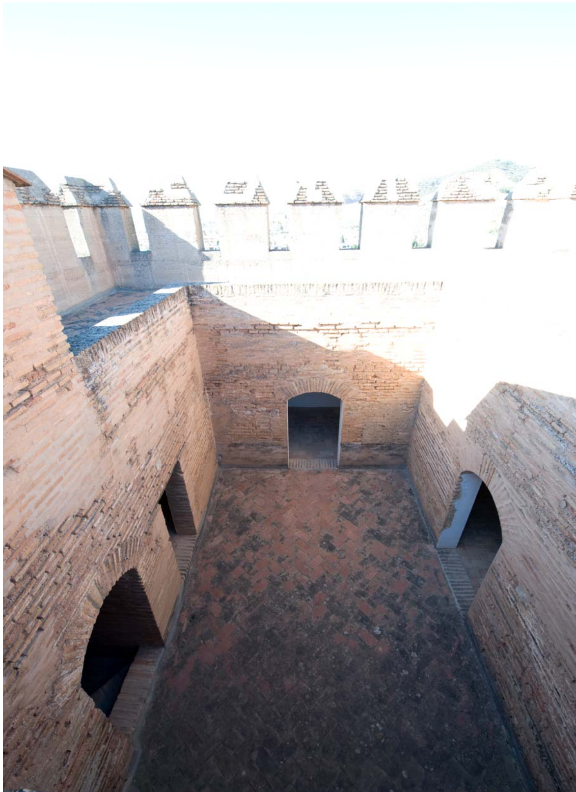
LÁMINA 20: PATIO INTERIOR EN LO ALTO DE LA TORRE DEL HOMENAJE. FOTOS: FIESTAS MORENO, M.
