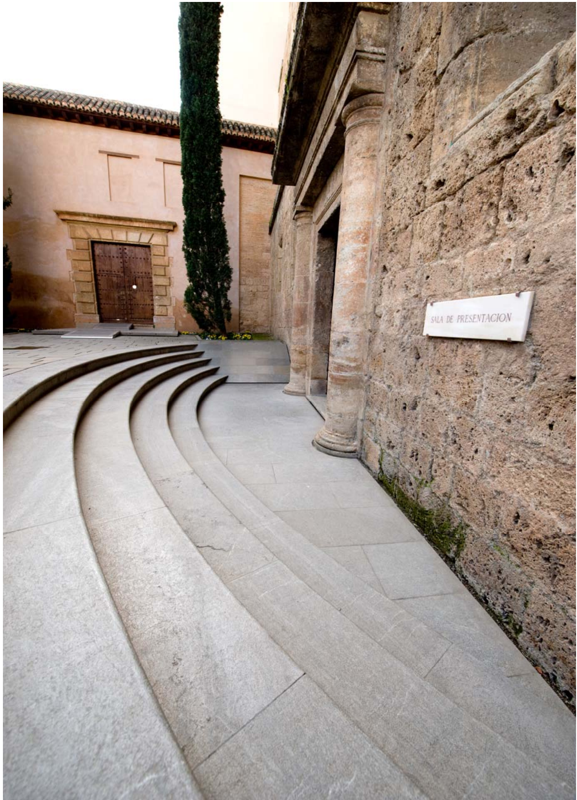
LÁMINA 121: FACHADA NORTE FRENTE AL MEXUAR. FOTOS: FIESTAS MORENO, M.
