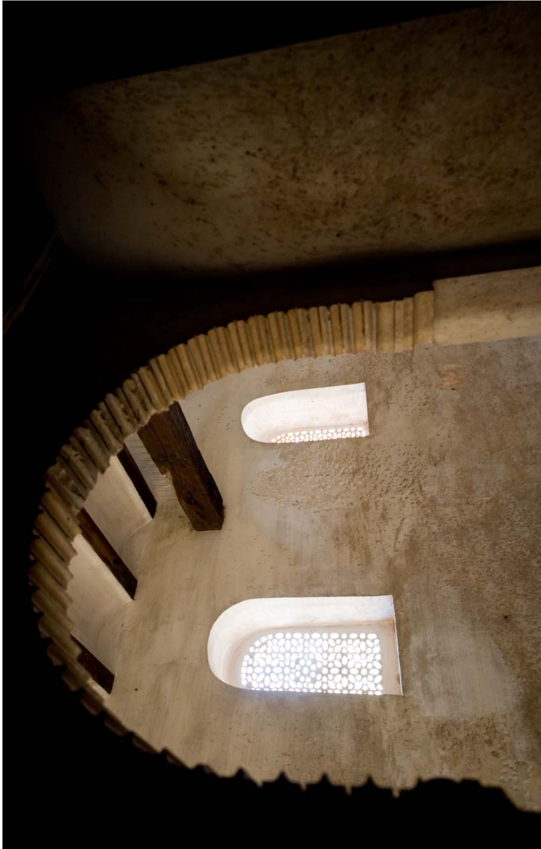
LÁMINA 82: DETALLE DE LAS CELOSÍAS DEL CORREDOR DE LA SALA ALTA DE LOS ABENCERRAJES. FOTOS: FIESTAS MORENO, M.
