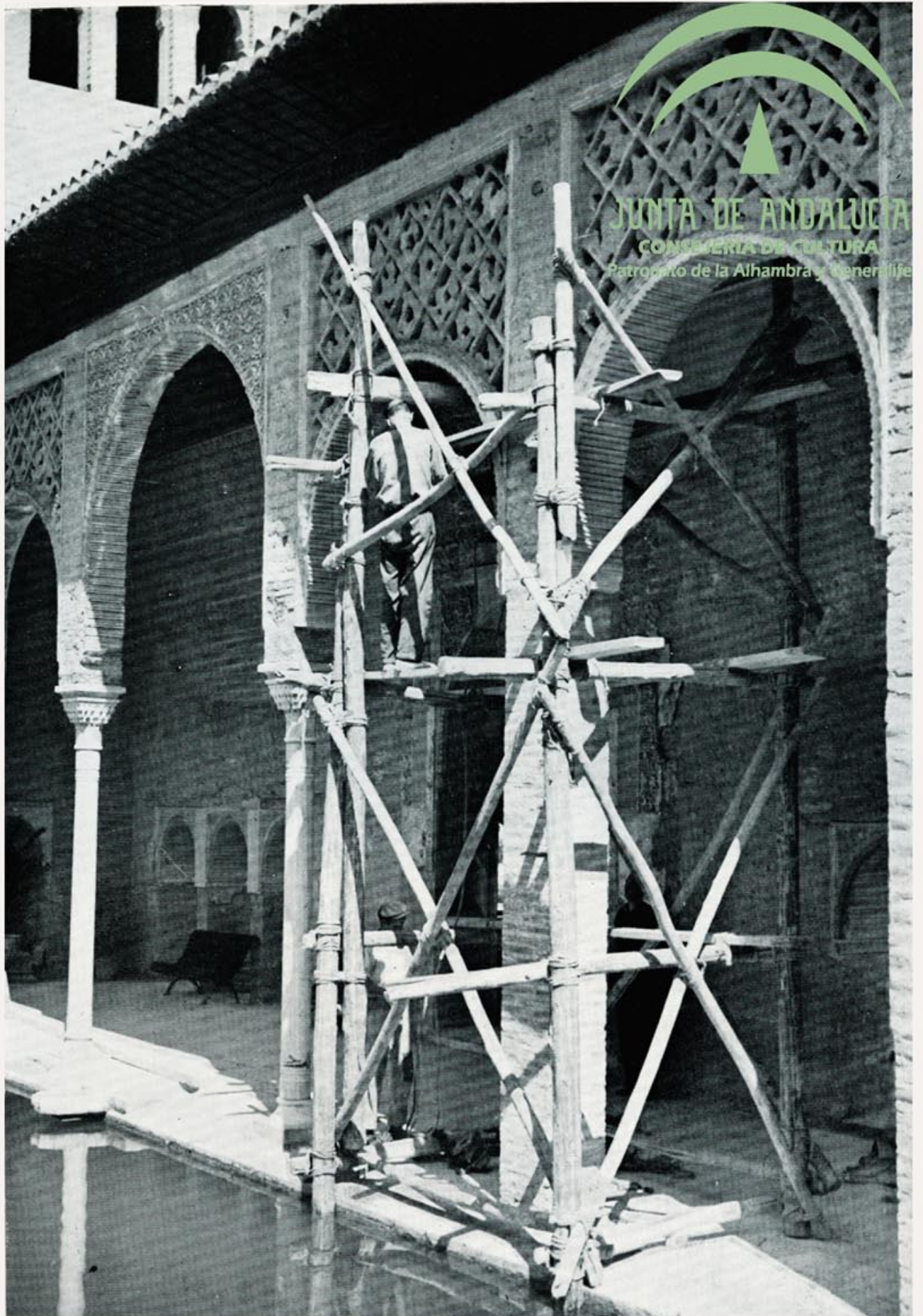
Pórtico del Partal durante los trabajos de la sustitución de los pilares por columnas. Foto López Murcia.
