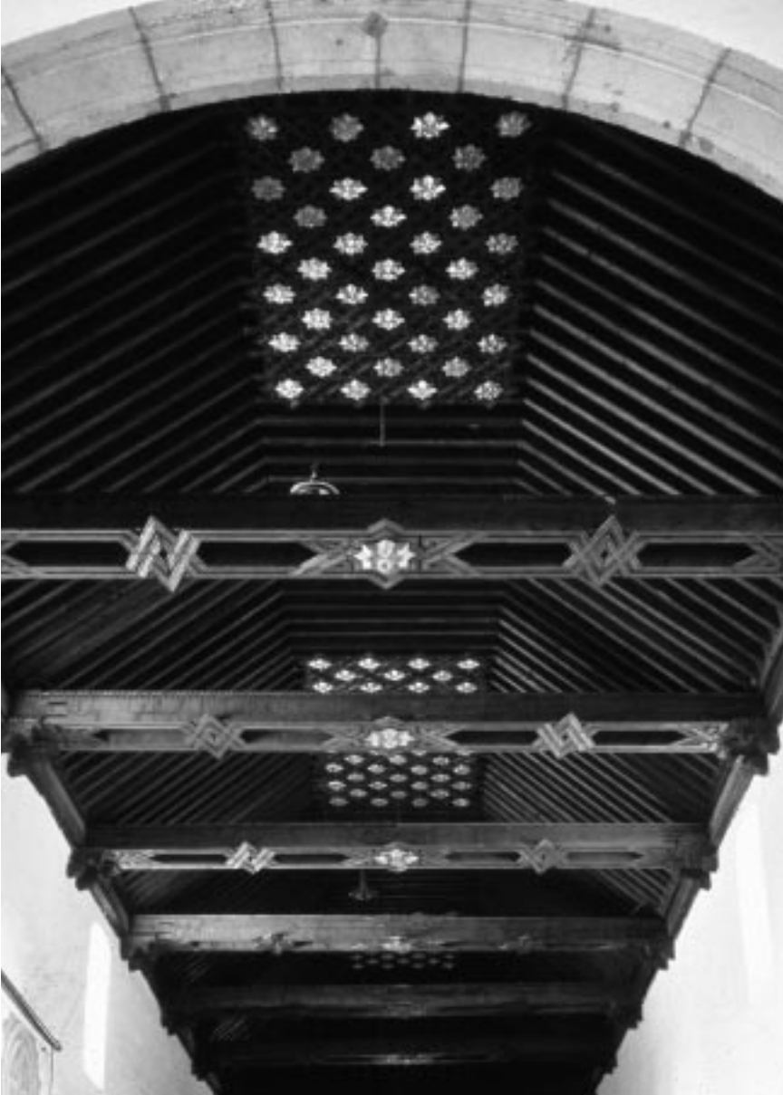
Fig. 8. Tlaxcala (México). Armadura de la iglesia de San Francisco.
