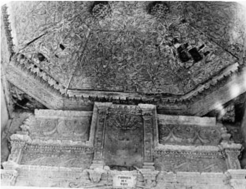
Figura 22. Techumbre de ochavo ataujerado y dos piñas de mocárabes en el pórtico de Santa María de Colaña, Castromocho.
