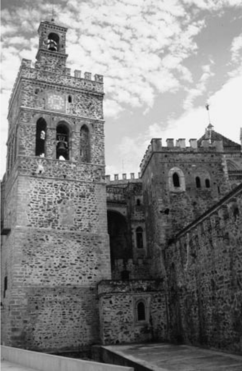
Fig. 5. Torre de las Campanas. El campanario se realizó extramuros pero comunicada con la muralla que protegía el recinto a través de arcos puente como una torre albarrana.
