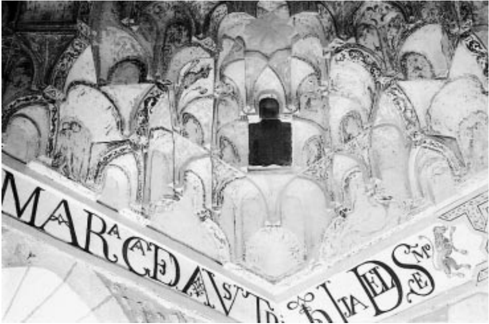
Fig. 8. Burgos. Monasterio de las Huelgas. Capilla del Salvador.
