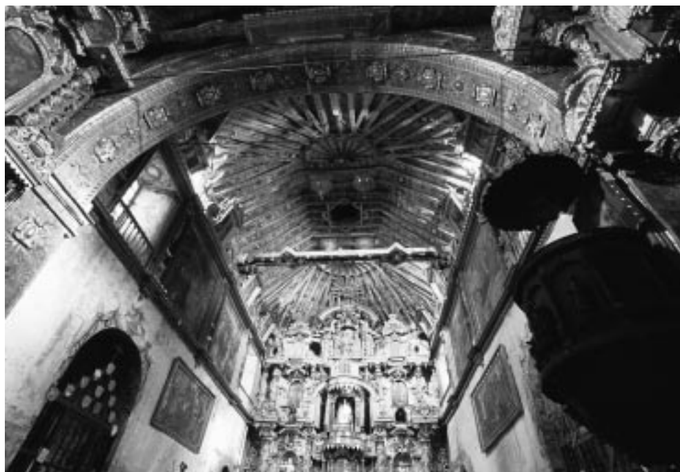
Fig. 16. Andahuayllas (Perú). Vista general de la Capilla Mayor.
