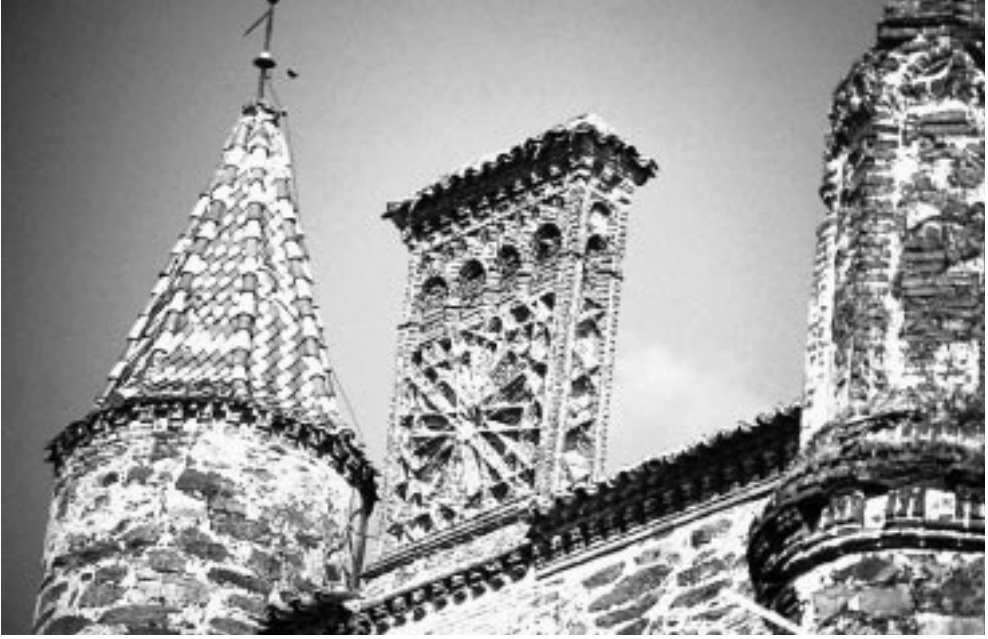
Fig. 12. Detalle del exterior del pabellón de la Botica y la Enfermería en el que encontramos decoración a base de ladrillo aplanillado dibujando lacería y tracería gótica.
