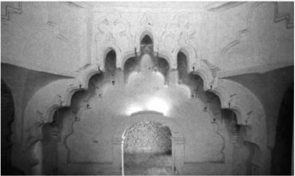
Fig. 16. Las Huelgas de Burgos. Capilla de la Asunción (detalle de las cubiertas).
