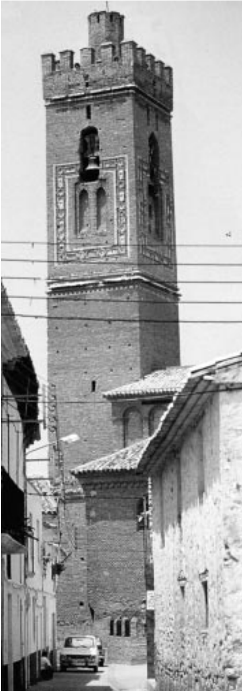
Fig. 10. Longares (Zaragoza). Iglesia de Nuestra Señora de los Angeles. Campanario. Esquina sureste. Fotografía de Agustín Sanmiguel Mateo.
