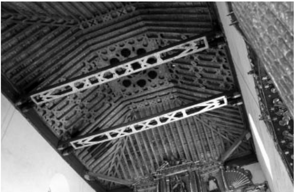
Fig. 10. Tunja (Colombia). Armadura de la capilla mayor de la iglesia de San Francisco.
