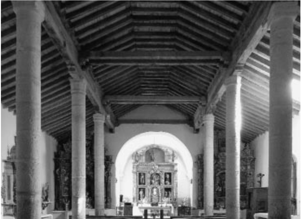
Figura 4. Interior de una iglesia de tres naves del tipo de Tierra de Campos, siglo XVI. Pozuelos del Rey, Palencia.
