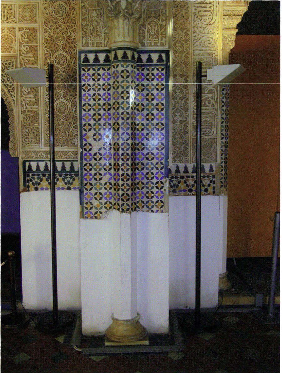
Fot. 7. Sala de los Reyes columna y pilastra del lado este. Las zonas desaparecidas han sido pintadas en color blanco puro, lo que resalta aún más la ausencia de alicatado.
