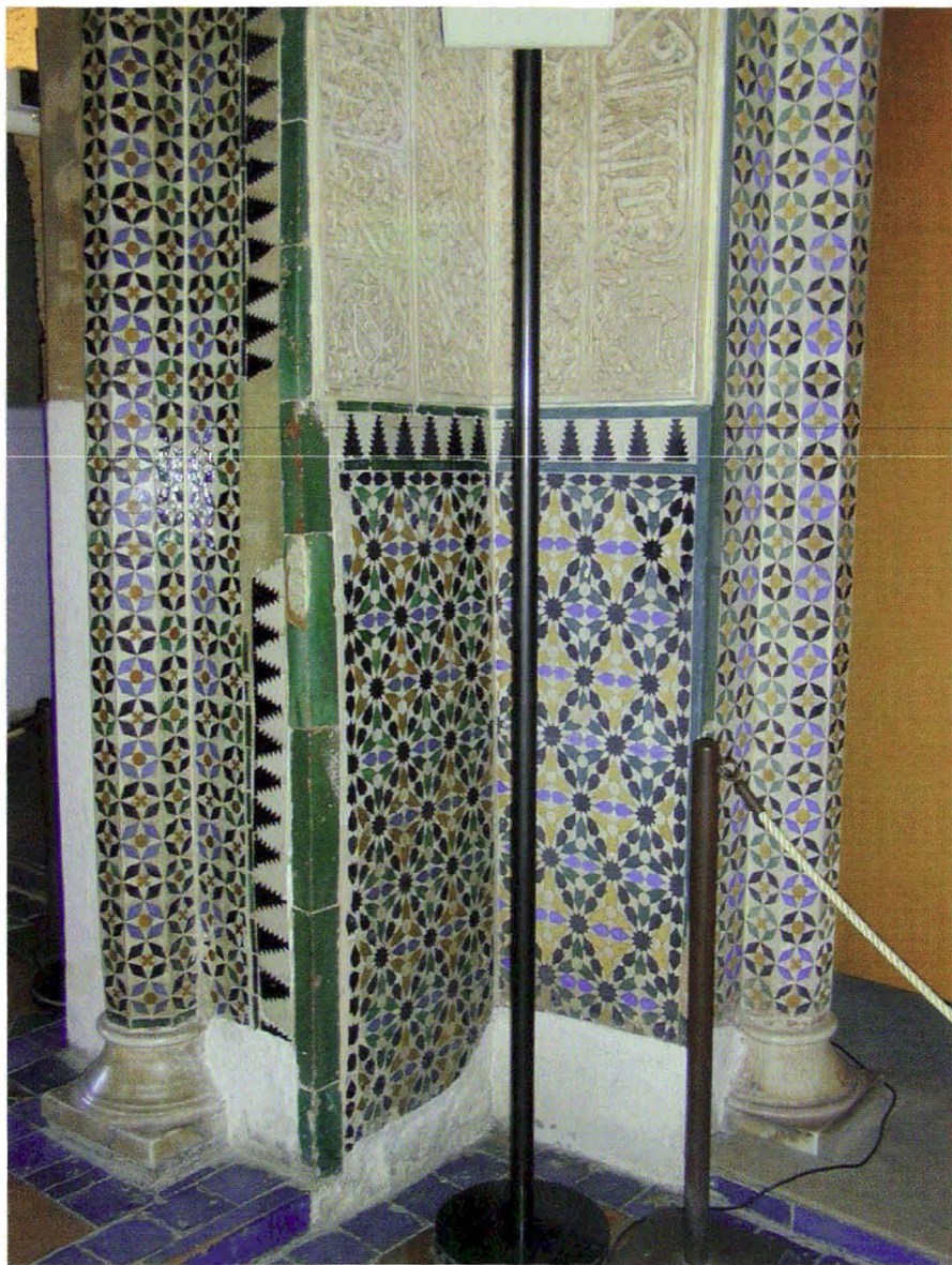
Fot. 3. Sala de los Reyes, esquina nordeste. La columna y el zócalo de la izquierda son alicatados originales, los de la derecha son reproducciones de estuco.
