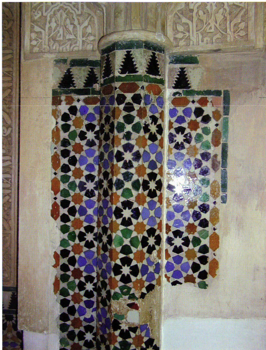
Fot. 4. Sala de los Reyes, columna y pilastra de la esquina noroeste que conservan el único alicatado original del lado oeste de la sala.
