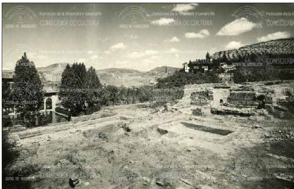
Lámina 3. Excavación de la zona de la Huerta de Santa María que ocupó parte del palacio del Partal Alto. (M. Torres Molina. 1930-1934. Archivo de Fotografías del Patronato de la Alhambra y Generalife)
