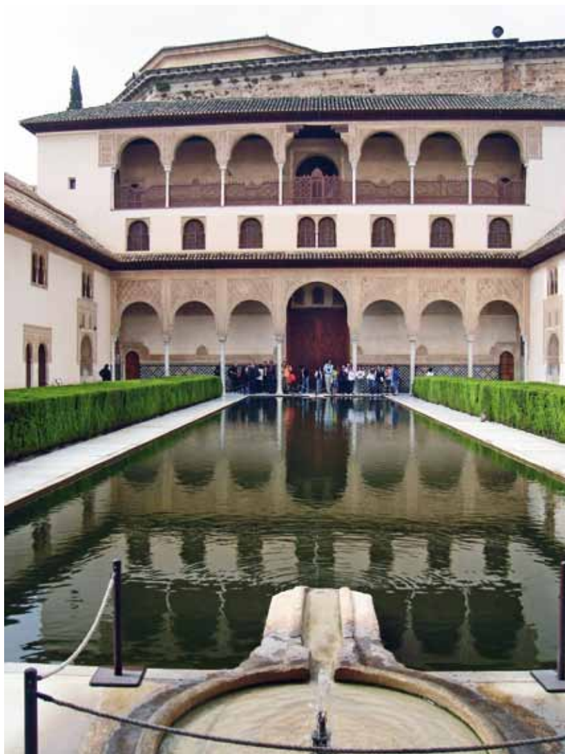
Fig. 59. Nave Sur del patio de Comares en la actualidad. (CVV. 2009)
