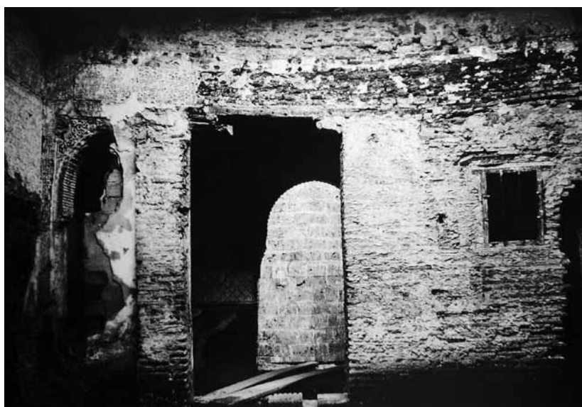
Fig. 86. Torres Molina (hacia 1920). Galería Occidental del Patio del Harém antes de la restauración de Leopoldo Torres Balbás.
