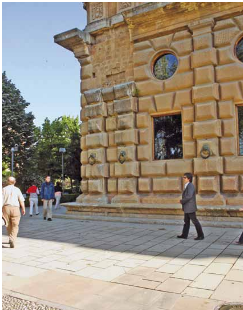
Fig. 20. Arranque del arco del ángulo S.O. del palacio de Carlos V. ( CVV. 2009).
