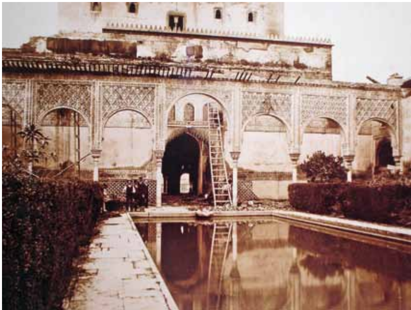
Fig. 65. V.Barrecheguren (1890). Sala de la Barca después del incendio. Exterior.
