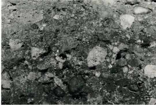
Lám. 14. Estado de conservación.
