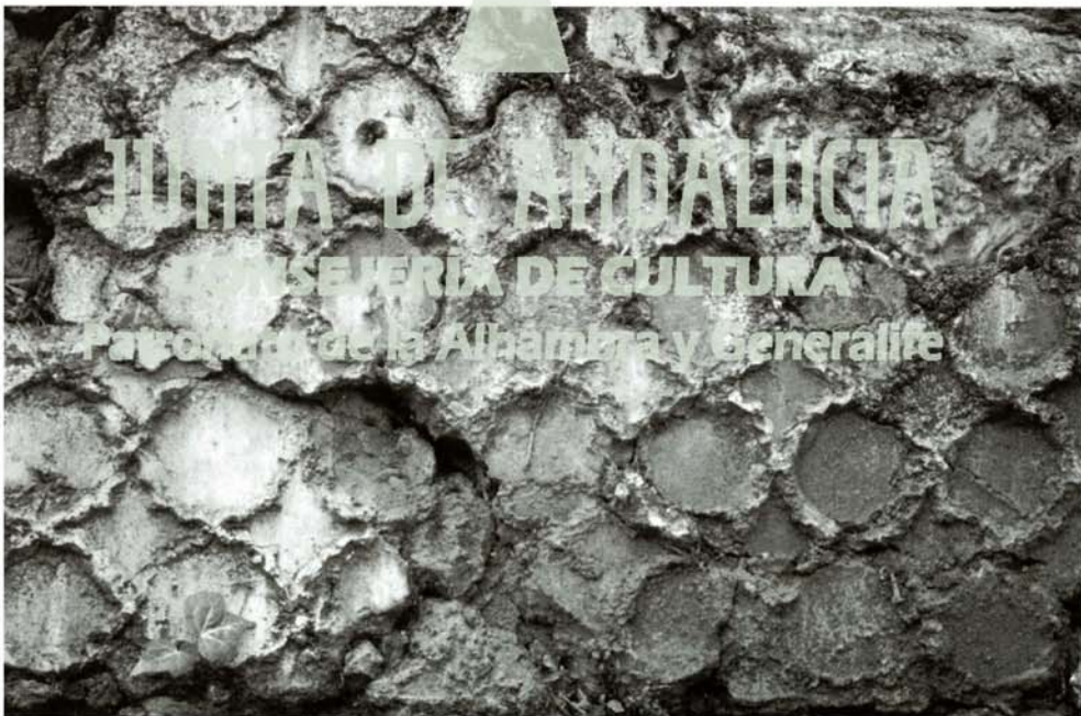
Lám. 4. Detalle del soporte de yeso con la huella de las piezas cerámicas.
