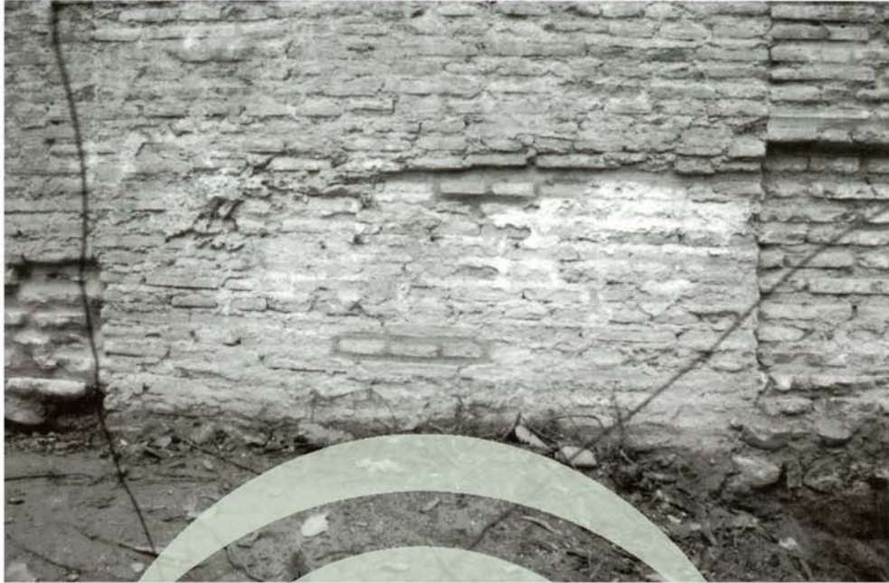
Lám. 5. Lugar que ocupaba el fragmento en el muro tras realizar su arranque.
