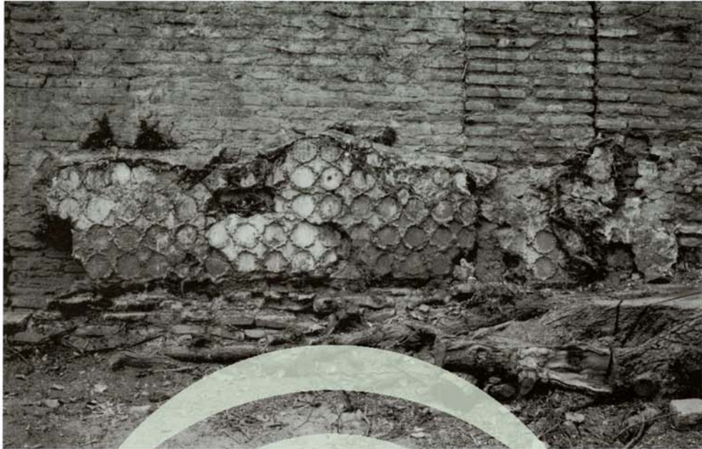
Lám. 3. Fragmento en el muro suroeste una vez eliminada la yedra.
