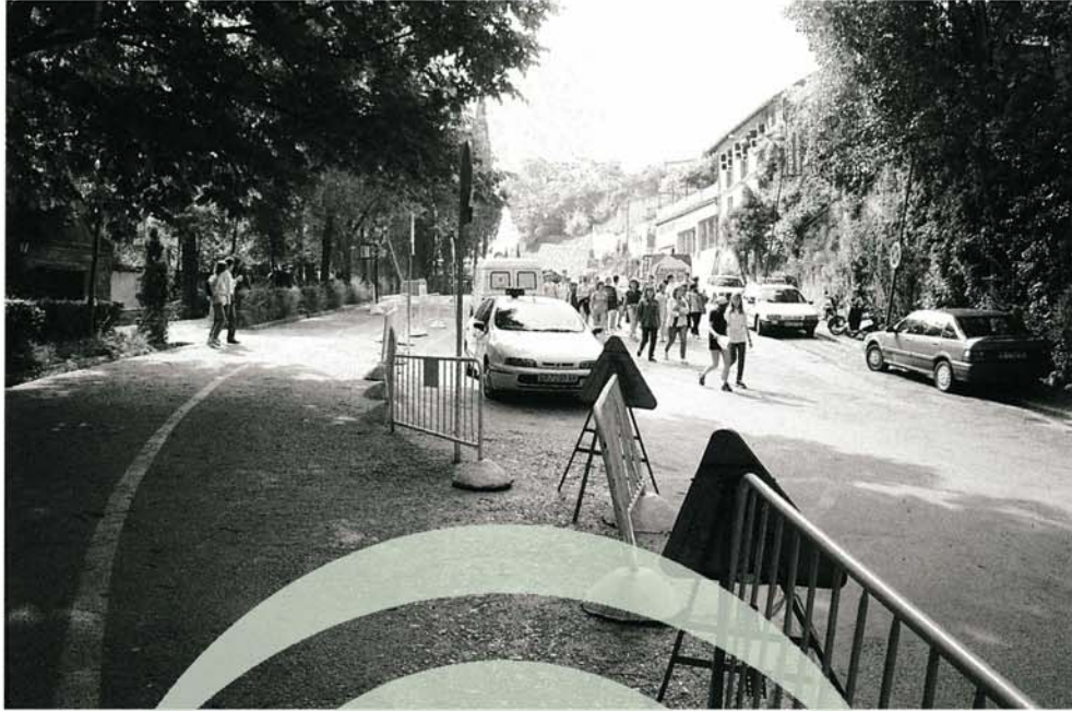
Lám. 17. Vista de esta zona durante las obras.
