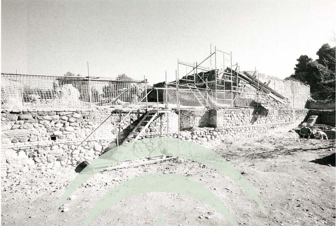
Lám. 21. Imagen del andamiaje colocado en la Silla del Moro.
