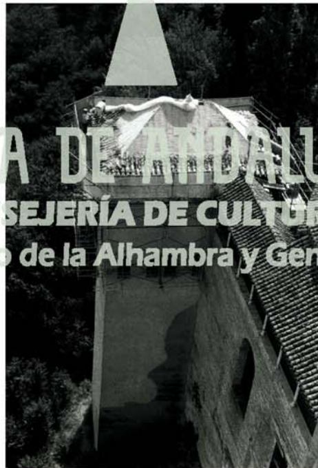
Lám. 11. Reparación de la cubierta del Peinador Alto, en la Casa Real.
