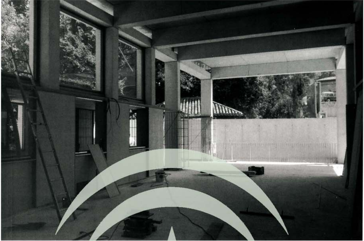
Lám. 8. Construcción del nuevo pabellón de acceso al Conjunto Monumental.
