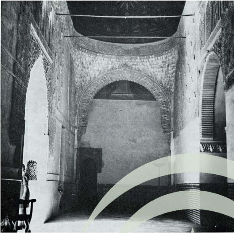
a) Alcoba O. de la sala de la Barca, atajada por un arco de mocárabe, faltando en su parte baja el estrado; a la izquierda, al fondo, se encuentra el arco de herradura que conduce a la letrina. (Foto: A. Fernández-Puertas).
