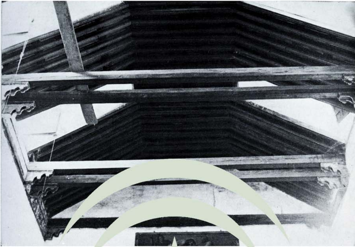
a) Armadura de par y nudillo con buhardas en la nave central del coro del Convento de Sto. Domingo el Real con vigas tirantes pareados sobre canes lobulados (último tercio del s. XV).
