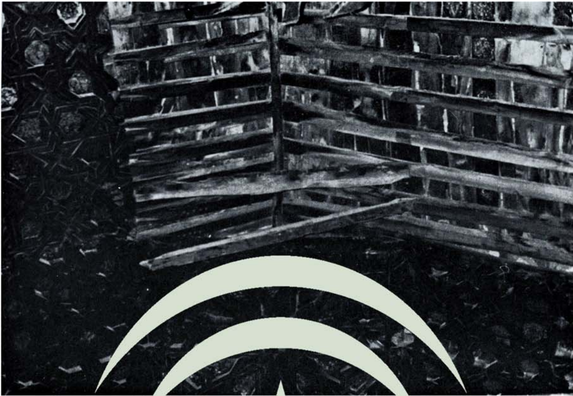
a) Armadura ataujerada del Palacio de Cárdenas en Ocaña (Toledo) donde se percibe el lazo ataujerado, los nudillos, pares e hileras (fines del s. XV).
