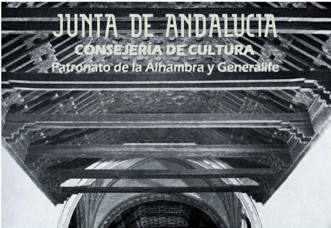
b) Armadura de par y nudillo en la nave axial del piso alto en el Hospital de Santa Cruz (comienzos del s. XVI).
