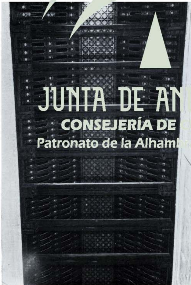
b) Armadura de par y nudillo de Santiago del Arrabal, con dobles tirantes, faldones almenados, crucetas con lazos de ocho en el almizate o harneruelo (fines del s. XIII o comienzos del XIV).
