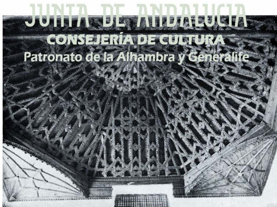
Dos aspectos de la armadura ochavada de la iglesia de Sta. Isabel con lazos de dieciséis y cuadrantes de la crucería (fines del s. XV).
