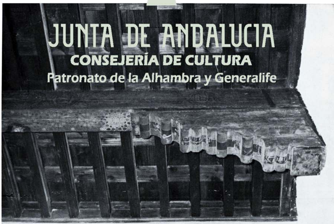
b) Can y jácena de un alfarje del Palacio de Fuensalida (fines del s. XV o comienzos del XVI).
