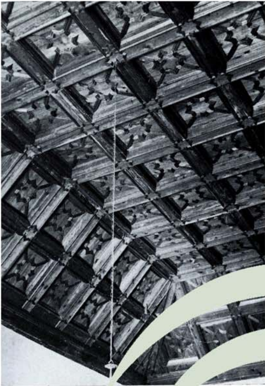
a) Armadura morisco-renaciente, con perfil de limabordon, en la Sala Capitular del Monasterio de Santo Domingo el Antiguo (comienzos del s. XVI).
