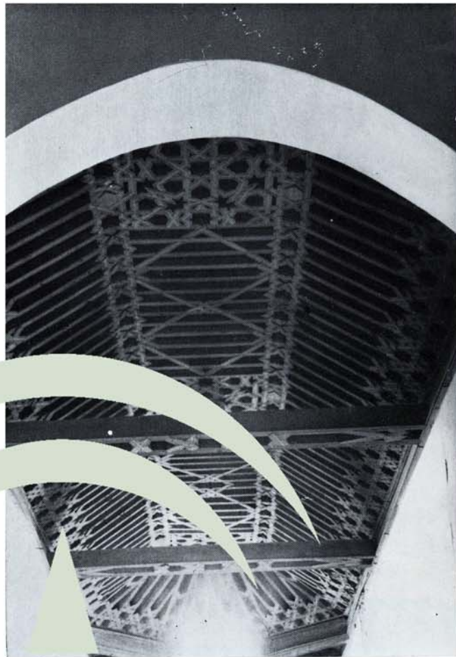
Conjunto y detalle de la armadura ochavada de la iglesia de Cabañas de la Sagra (Toledo) cuyas vigas tirantes ostentan lacería intermedia (s. XVI).
