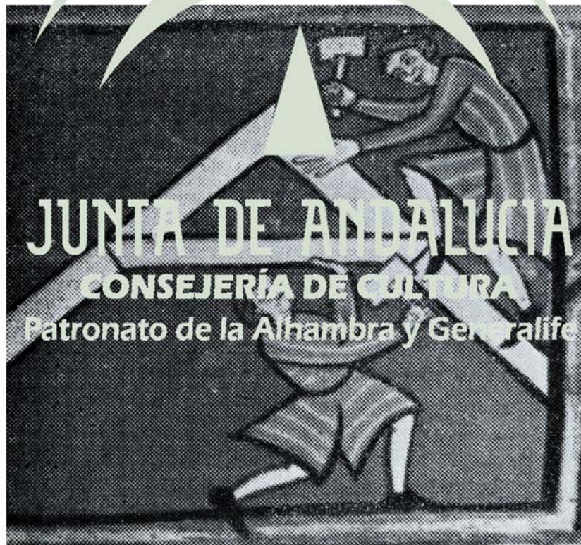
b) Dos carpinteros realizando una armadura de par y nudillo, representados en la techumbre de Sta. María de Mediavilla de Teruel.
