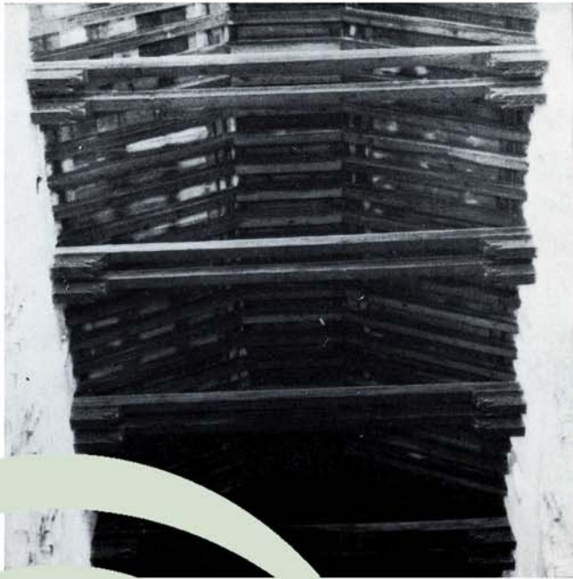
a) Armadura de par y nudillo con vigas tirantes pareadas, sobre canes, en la nave central de la Sinagoga de Sta. María la Blanca (s. XIII).
