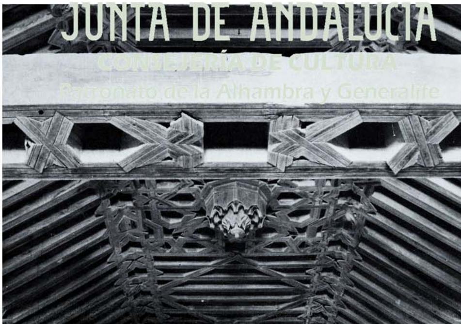
Conjunto y detalle de la armadura ochavada de la iglesia de Cabañas de la Sagra (Toledo) cuyas vigas tirantes ostentan lacería intermedia (s. XVI).
