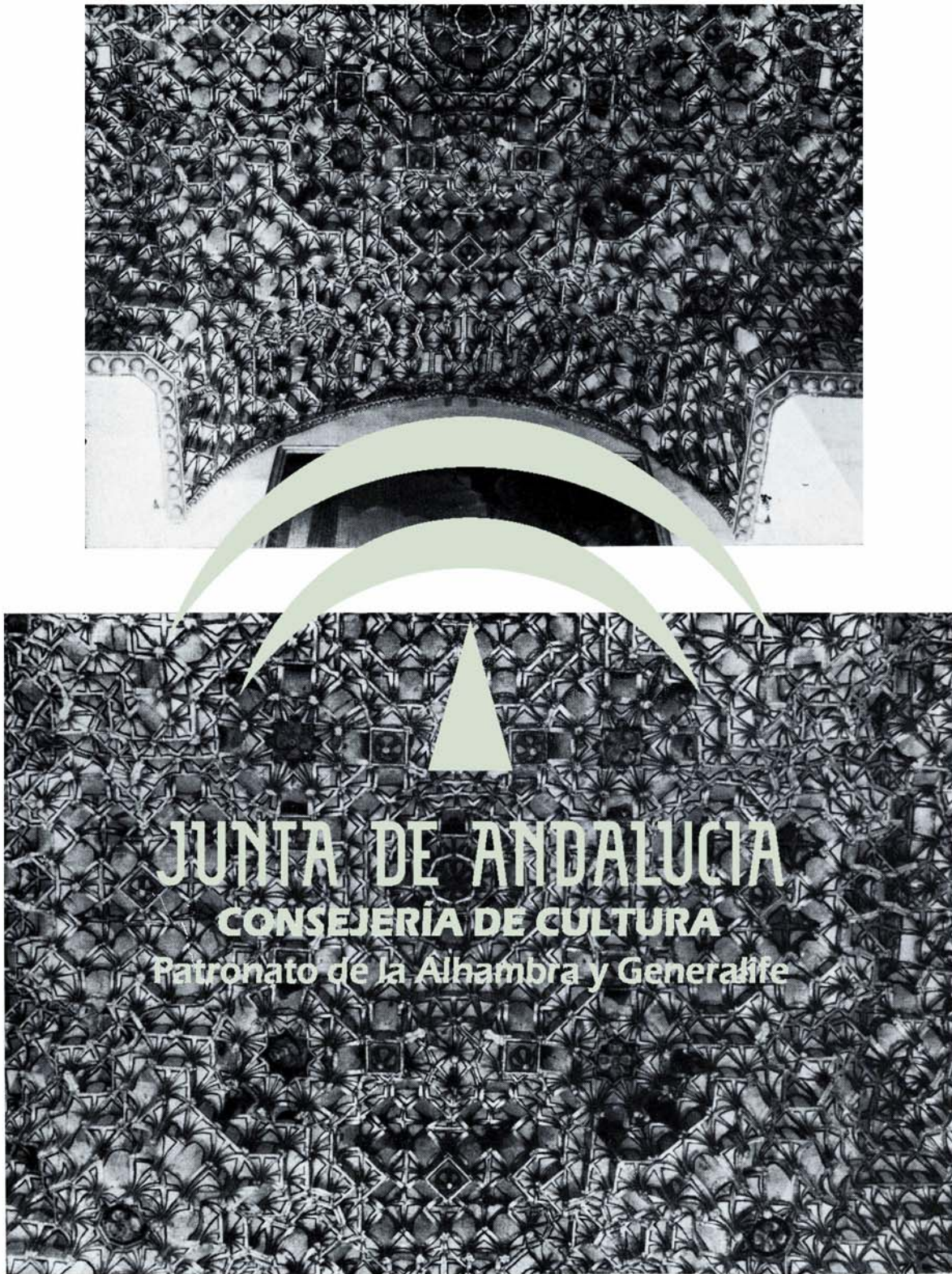
Detalles de la techumbre de mocárabes de madera en el Tesoro de la Catedral de Toledo (s. XIV).
