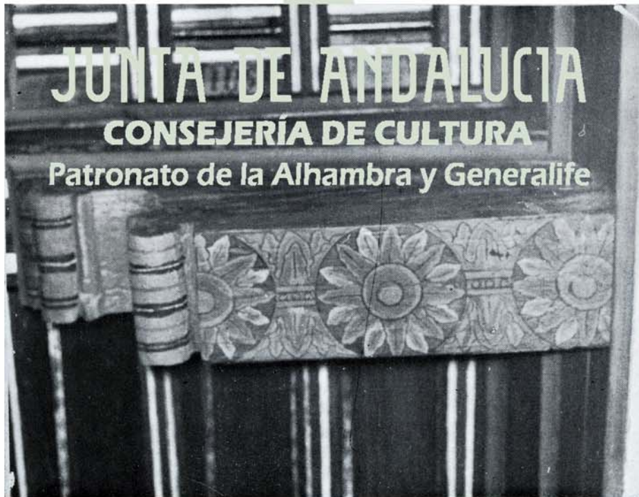
b) Detalle de un can o asnado del alfarje del Refectorio de Sto. Domingo el Antiguo (comienzos del s. XVI).
