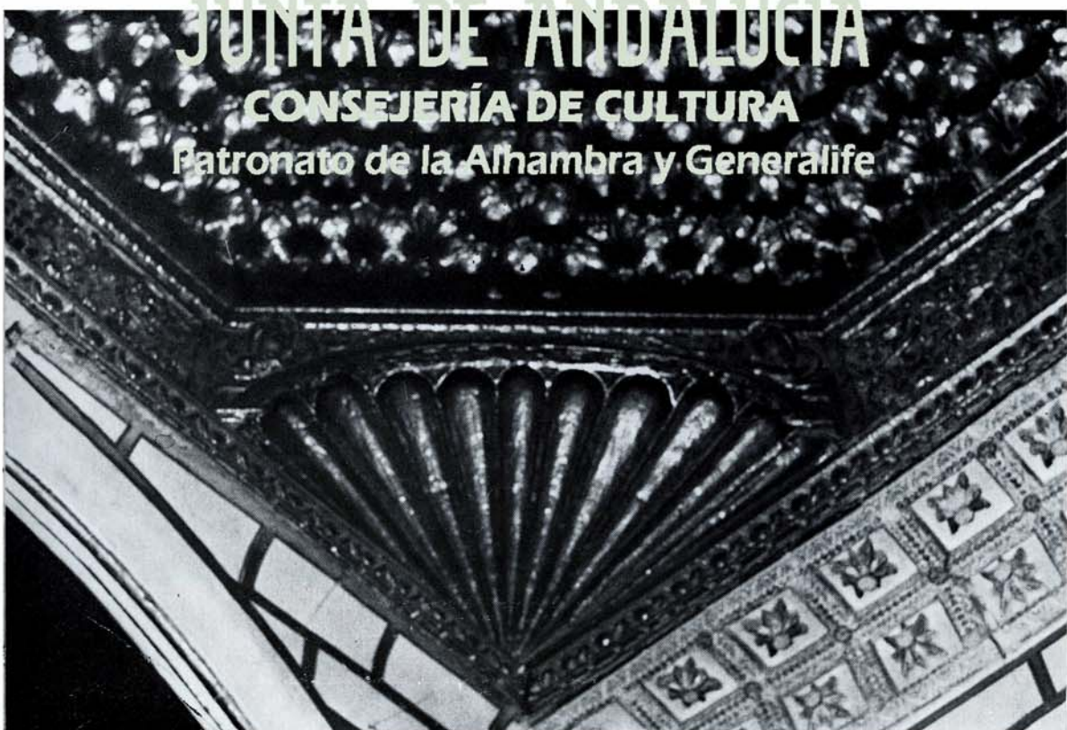
b) Detalle de la armadura de mocárabes de la capilla funeraria de los Condes de Cediño, en la capilla de Santa Catalina de la iglesia de San Salvador (s. XVI).
