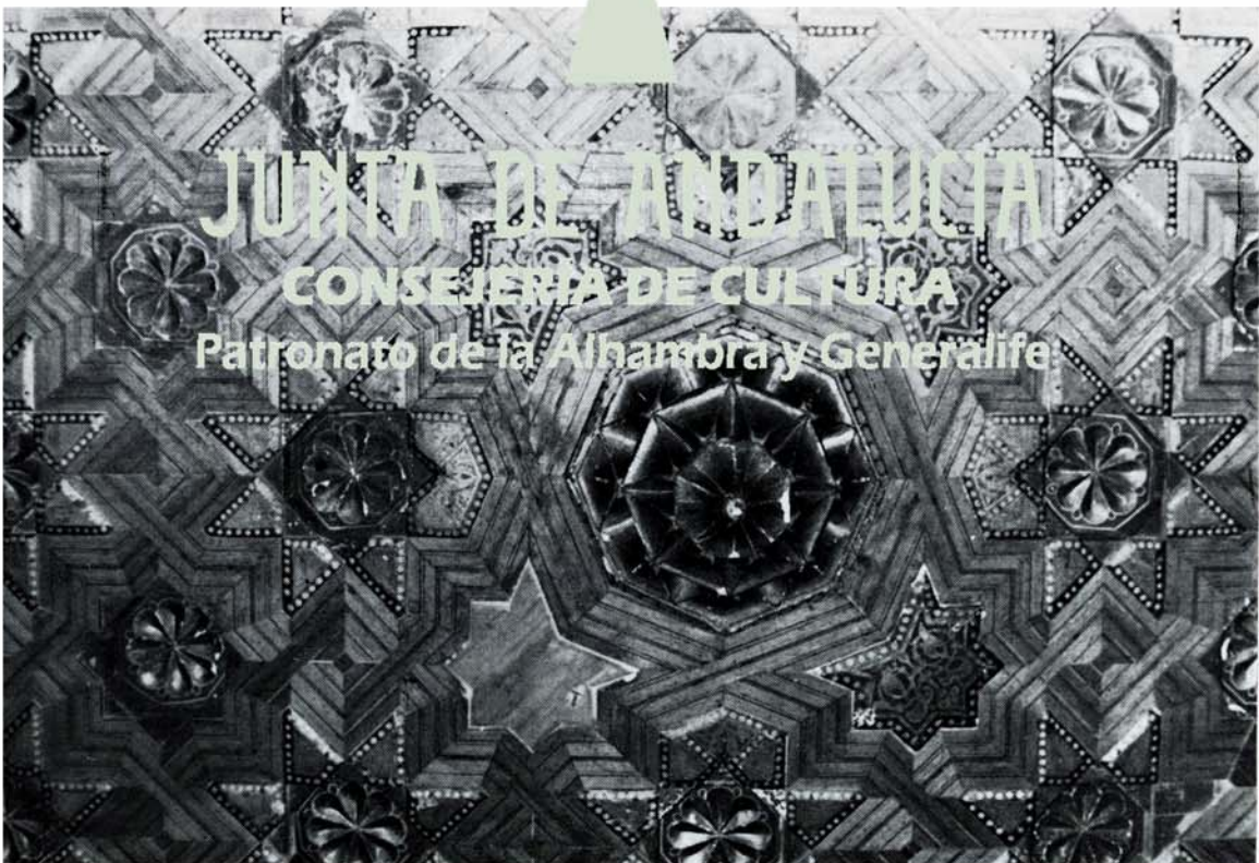
Monasterio de Santa Isabel. a) Armadura de par y nudillo sin tirantes de la antigua Sala de la Fundadora, con lazo octogonal (tercer cuarto del s. XV); b) Detalle del almizate o harneruelo con lazo octogonal y chillas gallonadas.
