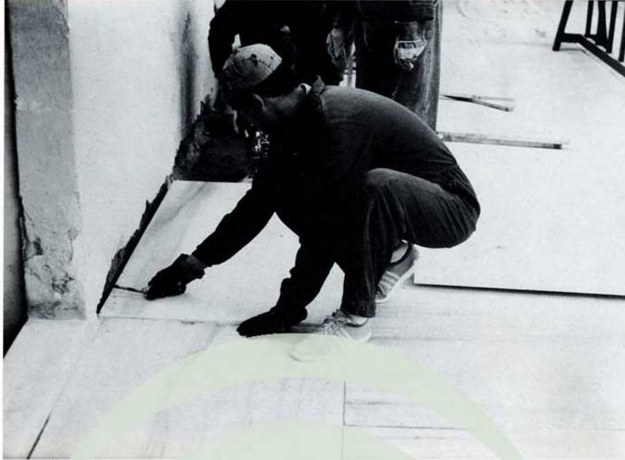
Lám. 40. Detalle del proceso de instalación de las losas de mármol tras la retirada de las jardineras.
