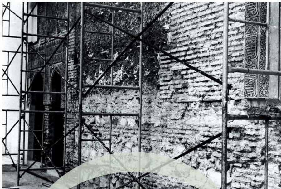
Lám. 44. Detalle de las fábricas del muro lateral del Patiò de los Arrayanes antes de recibir el nuevo mortero de cal y arena.
