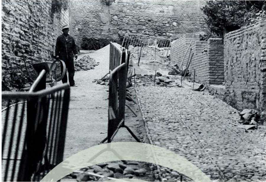
Lám. 32. Renovación del pavimento de la calle entre la Puerta de la Justicia y la Puerta del Vino.
