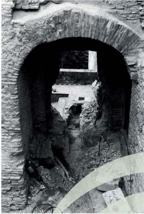
Lám. 24. Lugar de aparición de la tubería.
