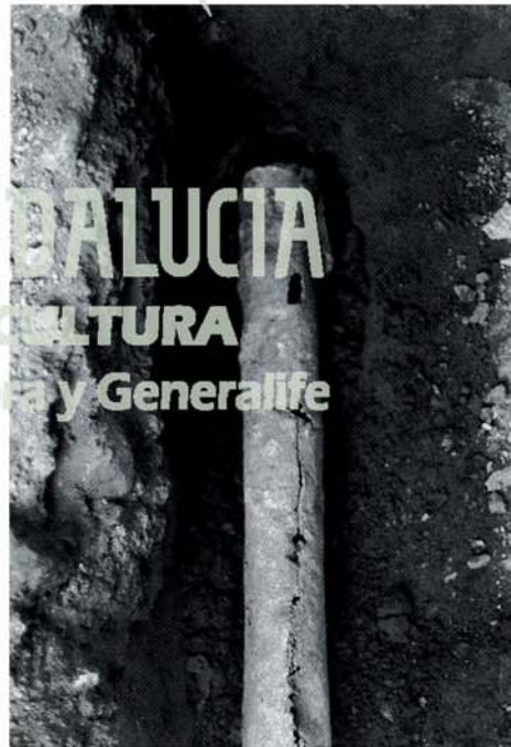
Lám. 27. Detalle de la unión de la tubería de plomo al caño de barro.
