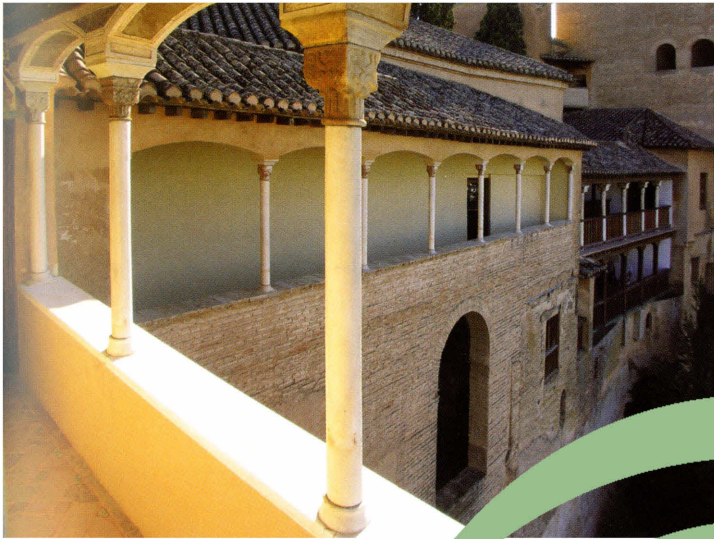
Continuidad de las galerías del Peinador con la del patio de la Reja. Archivo: GMC
