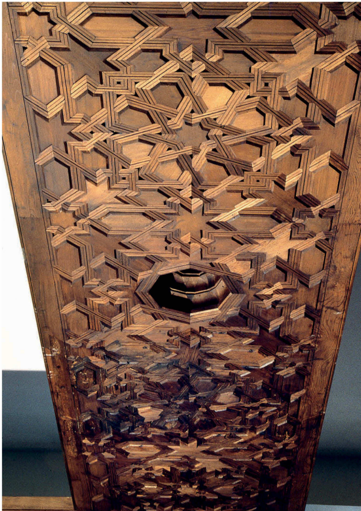
Detalle del techo de la sala de reposo de los baños, una vez restaurado. Archivo: E. Nuere
