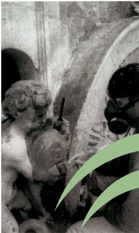
Lámina 7. Primer tratamiento de consolidación aplicado por impregnación en el putto superior izquierdo. Detalle del aspecto que presenta la boca y la conducción interior del surtidor.
