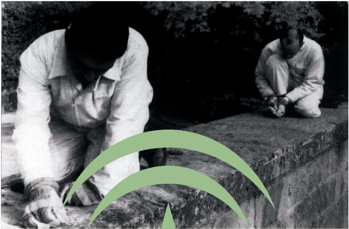
Lámina 3. Limpieza mecánica: eliminación de musgos y líquenes tras la desinfección en el muro de la fachada.
