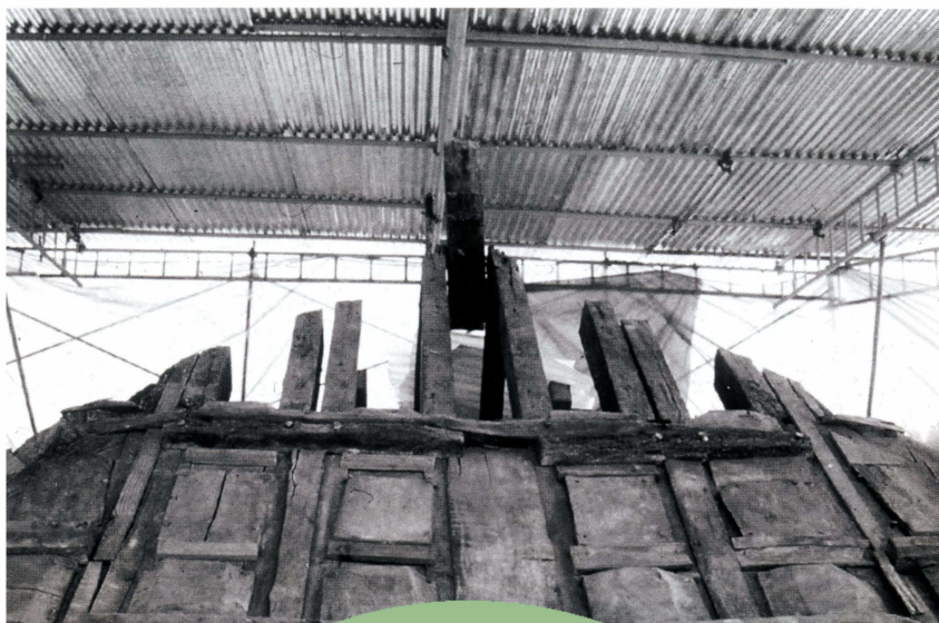
Lámina 2. Armadura del Cuarto Real de Santo Domingo, durante las obras de restauración realizadas recientemente. Lo primero que llama la atención es la falta de hilera, lo que va en detrimento de la estabilidad del conjunto.
