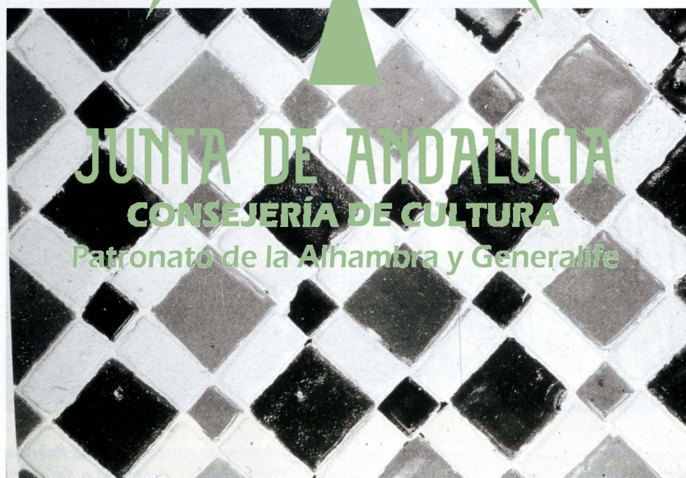
Lámina 8. En los zócalos el alicatado resiste roces y posibles humedades del terreno.
