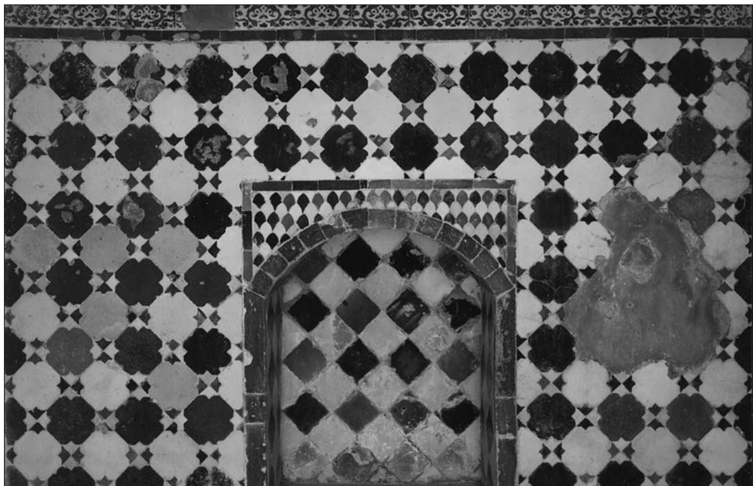
Fig. 8. Alicatados en una de la pilas de bayt al-sajum . Baño de Comares. Alhambra de Granada. (Foto: Vicente del Amo).
