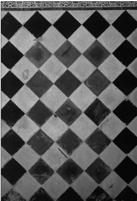
Fig. 6. Alicatados en una de las salas contiguas a la Sala de las Camas. Baño de Comares. Alhambra de Granada. (Foto: Vicente del Amo).
