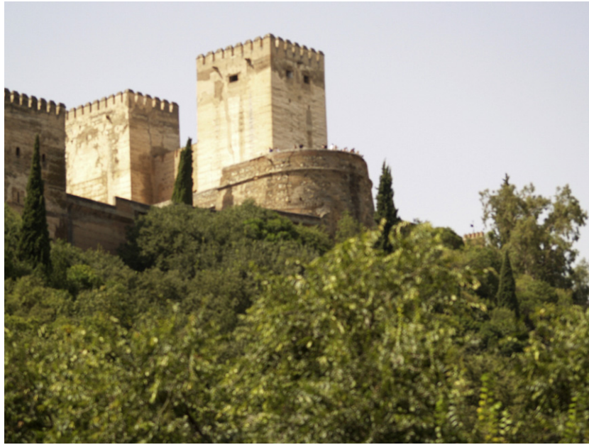
Fig. 12. Crack in Torre de la Vela.
