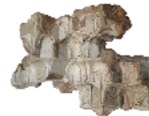
DICIEMBRE Bóveda mocárabe iwān SO. Patio de Comares. Sistema constructivo Gloria Aljazairi López
